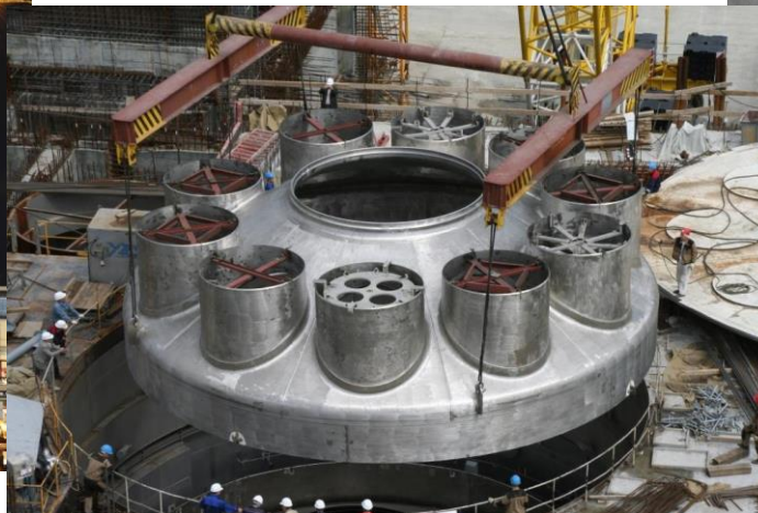
Монтаж крыши реактора
