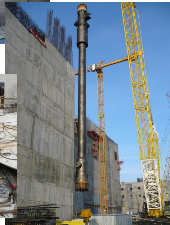
Монтаж модуля ПГ
