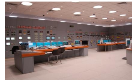
Блок 1 Балаковская АЭС ПМТ для блока ВВЭР-1000
