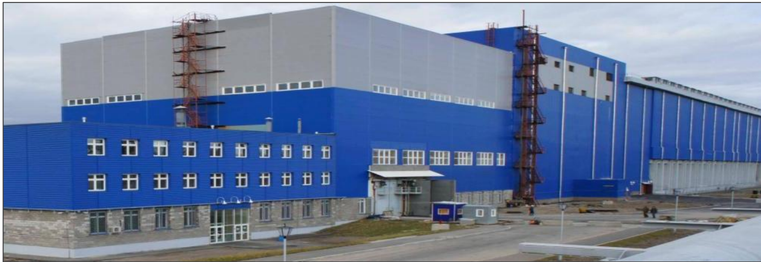
Централизованное воздухоохлаждаемое «сухое» хранилище ОЯТ РБМК-1000
