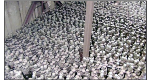
Пристанционные хранилища ОЯТ заполнены на 96%
